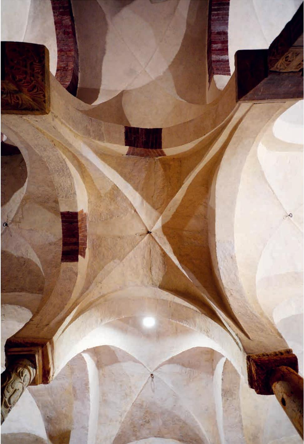
*Fig. 30.* Verona, San Benedetto, interno. Volta a crociera mediana.
