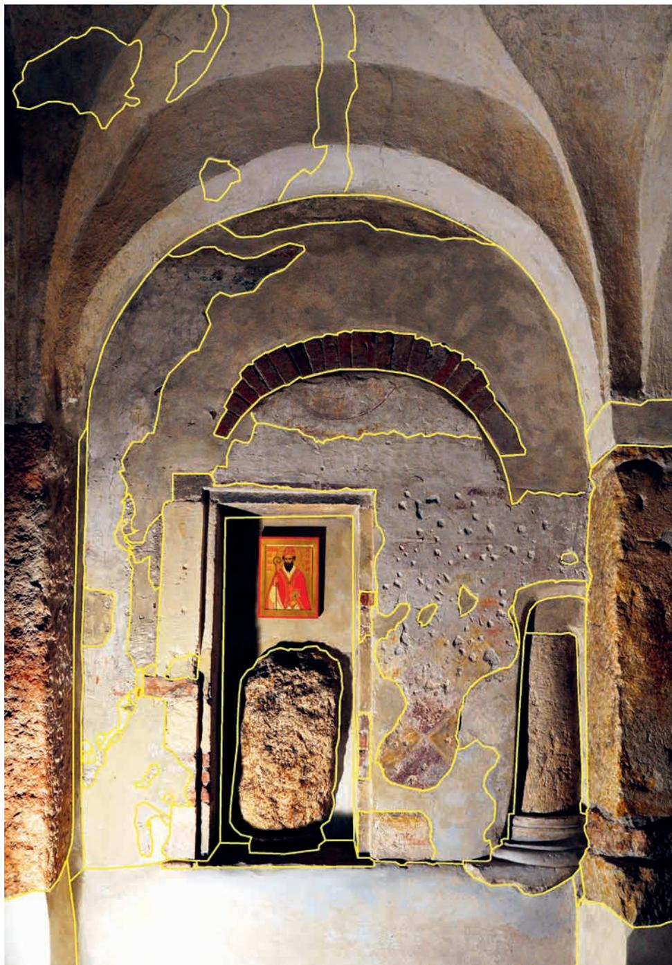
*Fig. 7. Verona, San Benedetto, interno. Particolare del muro settentrionale con la porta tamponata nella campata mediana (foto ed elaborazione grafica F. Coden).*
