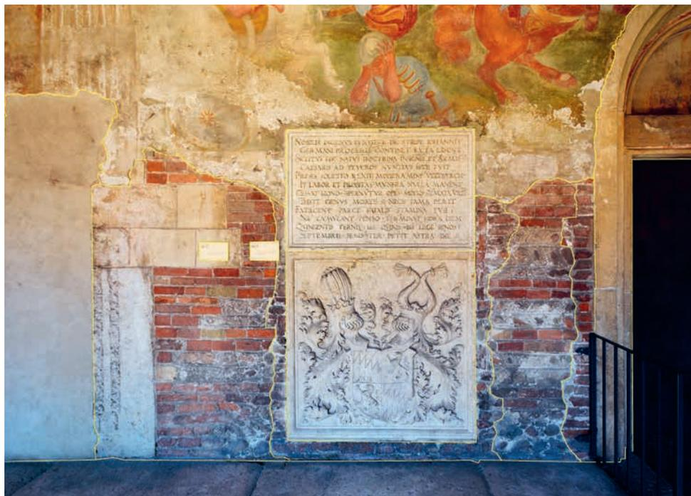
Fig. 18. Verona, San Benedetto, esterno. Prospetto anteriore della facciata verso nord, con le unità stratigrafiche in giallo (foto ed elaborazione grafica di F. Coden).
