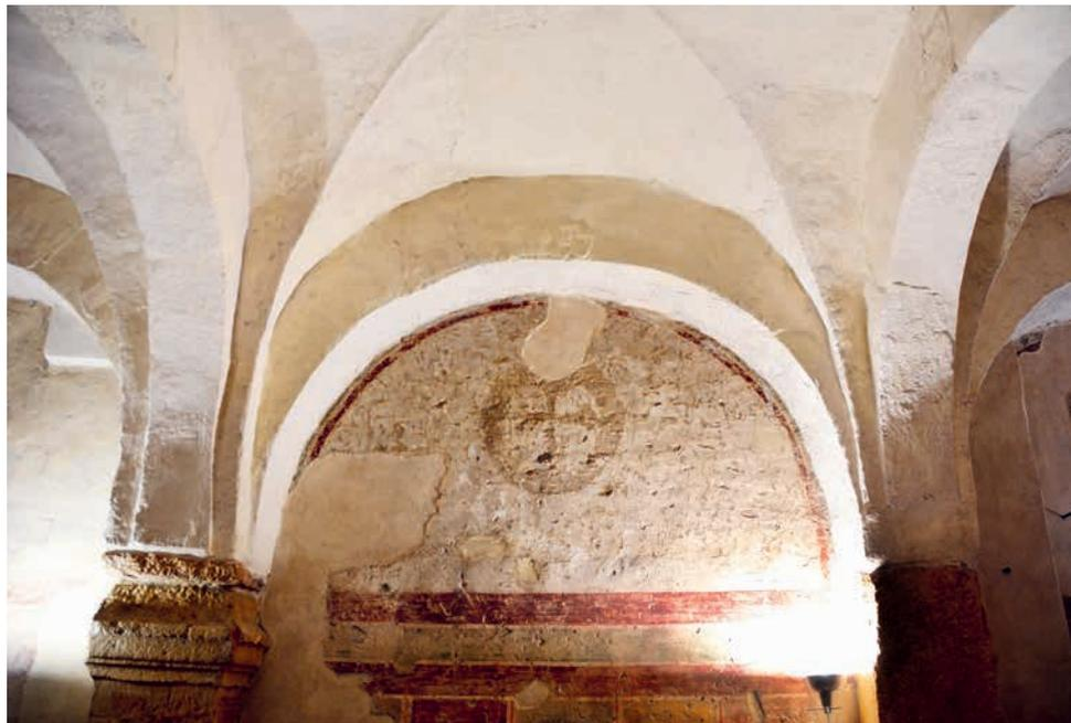
Fig. 26. Verona, San Benedetto, interno. Particolare con il punto di contatto fra l'arco incastrato e il muro perimetrale sud.
